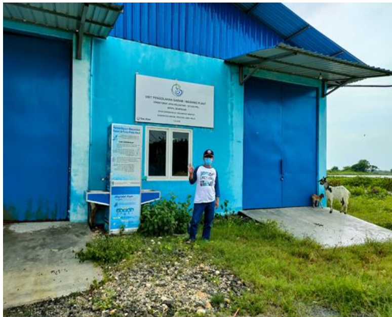
Gambar 3.21: Unit Pengolahan Garam / Washing Plant di Desa Karangrejo Kecamatan Manyar
